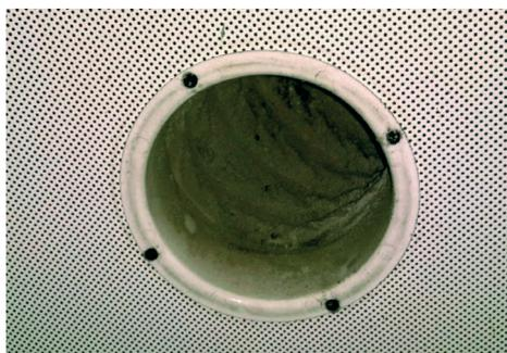
Fig. 4.4 Negli impianti centralizzati le tubazioni tendono ad accumulare polvere nel tempo, perciò hanno necessità di manutenzioni frequenti e accurate.
