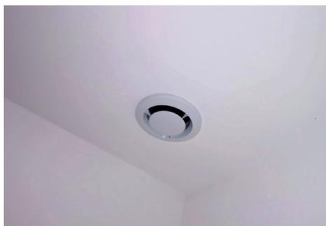
Fig. 4.2 Bocchetta di ripresa di un apparato di ventilazione meccanica centralizzato.
