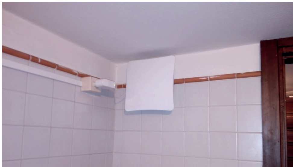
Fig. 2.8 I sistemi di ventilazione a semplice estrazione sono adatti solo nei locali dove si produce localmente molto vapore come bagni e cucine.
