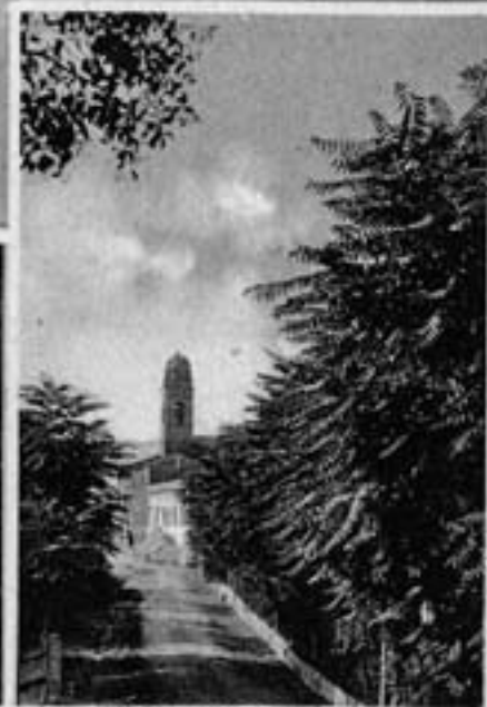
PARTICOLARE CASA G. I. L.
